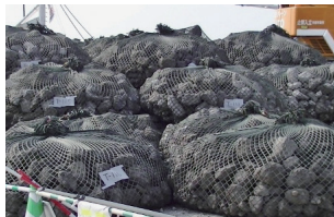
潜堤構築材（中詰材：鉄鋼スラグ水と固化体）
