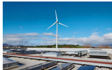
ケリー工場のソーラーパネルと風力発電
