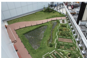
戸塚区総合庁舎8階屋上に整備した農園と水田
